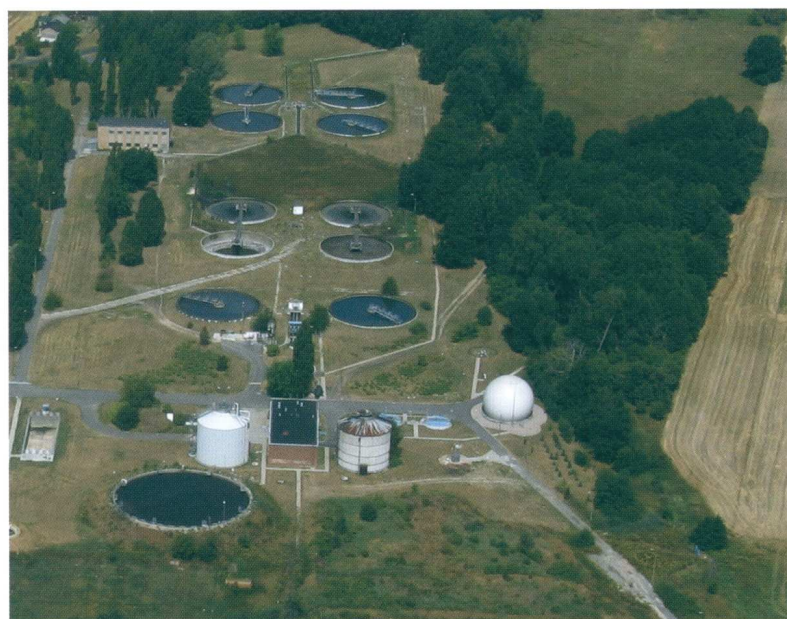
Oczyszczalnia w Grodzisku z lotu ptaka
